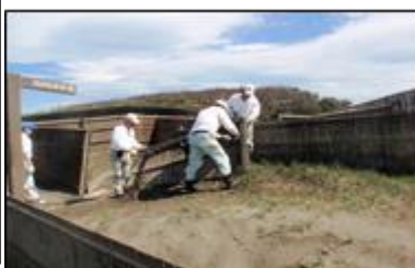
強風によって倒壊した竹柵修繕
