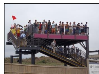
津波避難タワー
