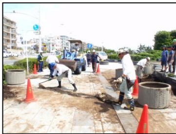
器物損壊（植栽・土壌の散乱）
