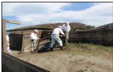
強風によって倒壊した竹柵修繕
