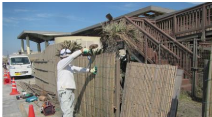
強風によって倒壊した竹柵修繕
