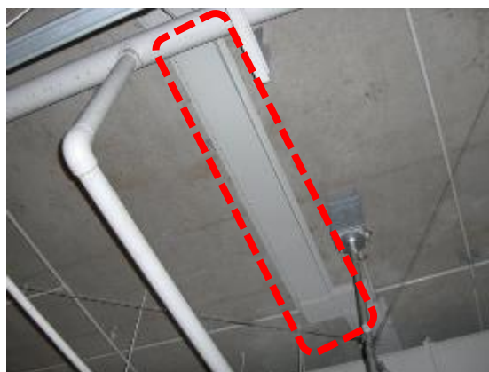
図 招き灯の交換（左）、排水版の設置（右）
