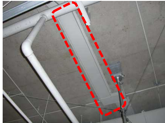
図 招き灯の交換（左）、排水版の設置（右）
