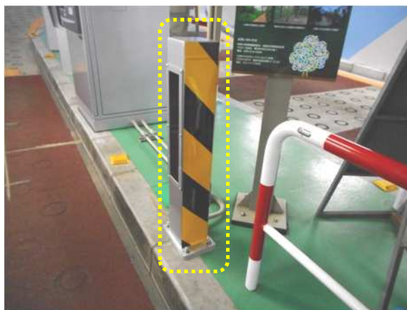
図 出口車番トリガーセンサーポールでの注意喚起
