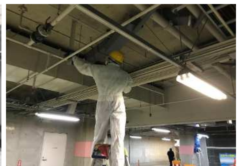
図 シャッターの水洗い（左）、場内の粉塵除去作業（右）
