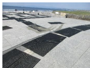
ゴムマットの敷設
