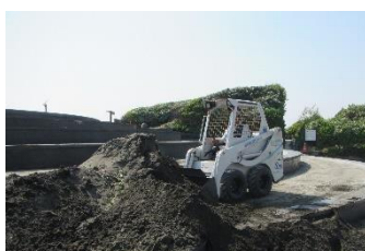
自社重機による 堆砂除去
