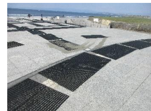
ゴムマットの敷設
