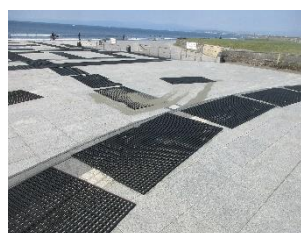
ゴムマットの敷設
